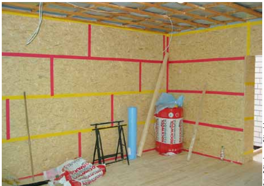
Bild 6: Innenseitige Dämmung der Außenwand mit gleichzeitiger Dämmung der Verbindenden Innenwand
