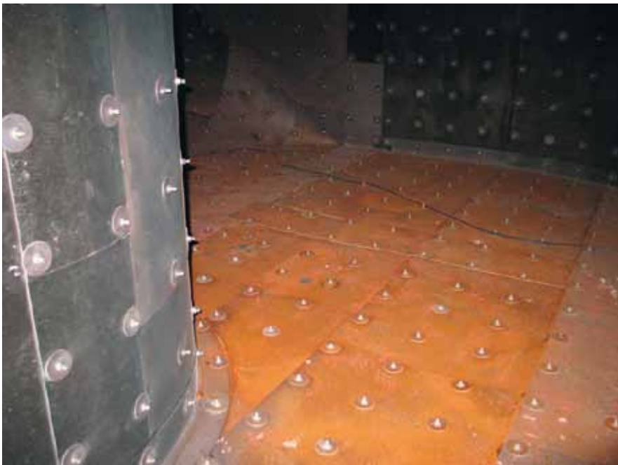
Bild 4: Innenbekleidung in einem Rauchgaskanal
