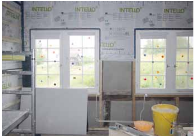
... und während des Anbringens der Dämmung
